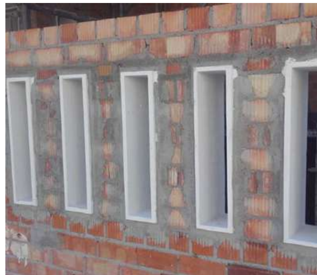
HUECOS PARA CERRAMIENTO
