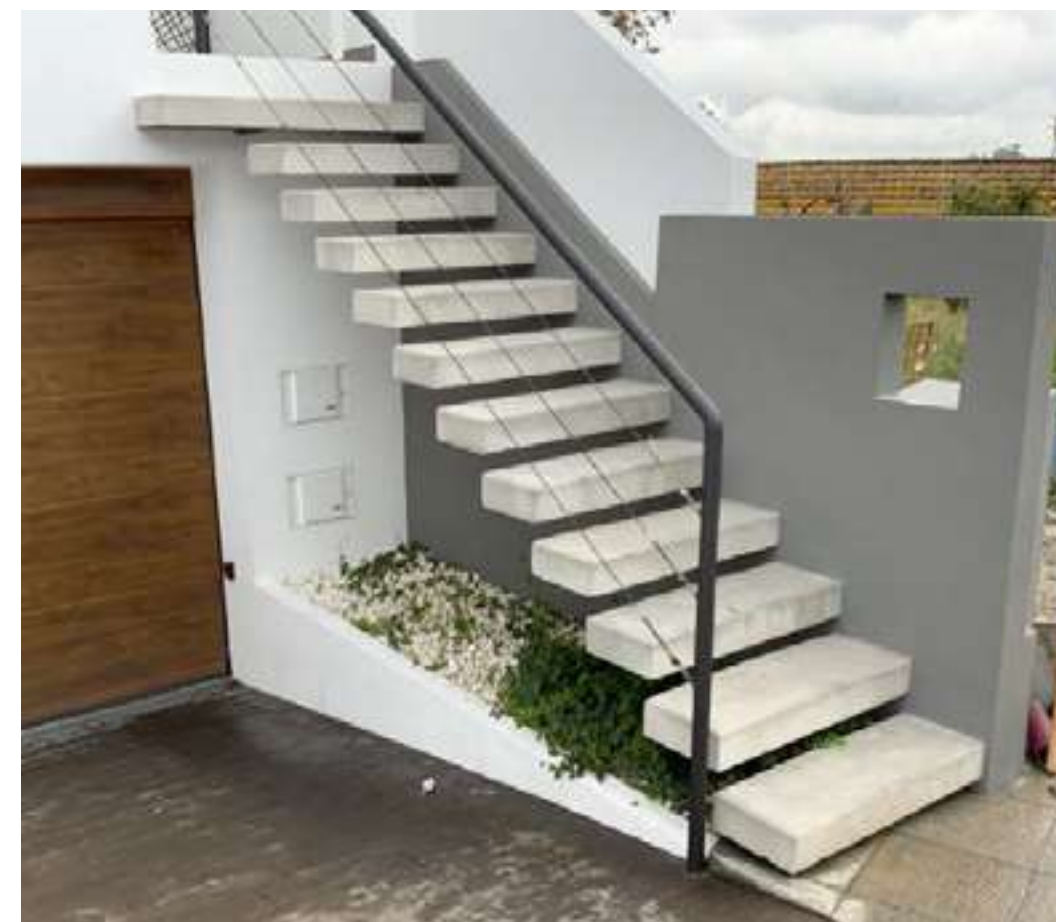
PELDAÑOS DE ESCALERAS
