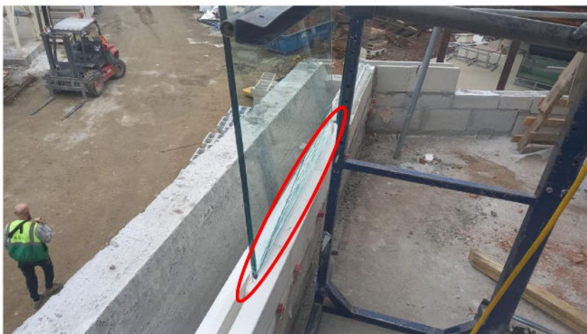
Fotografía n°3: Rotura cristal.
